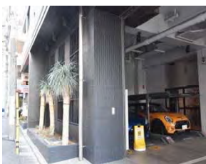
基礎立ち上がり
