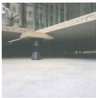
無垢のフローリングを使う場合、床面に防音加工を施します。人気の無垢のフローリングも、階下を気にせず楽しめます。
