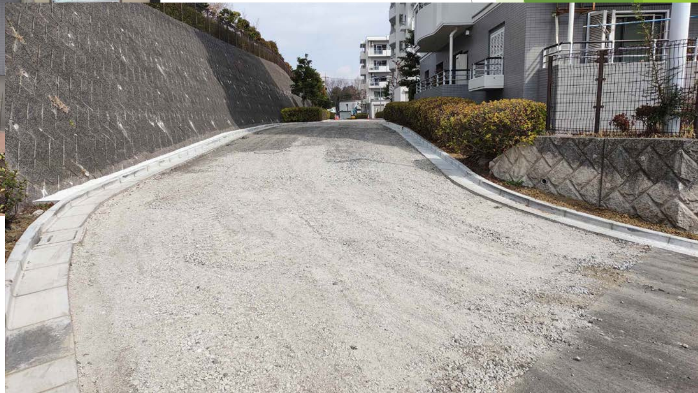
団地内通路の舗装
