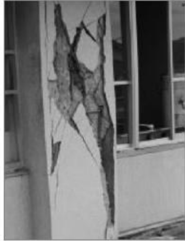
▲柱のせん断破壊
