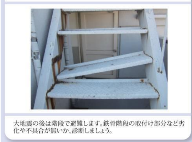
阪神淡路大震災 鉄骨階段が転倒
