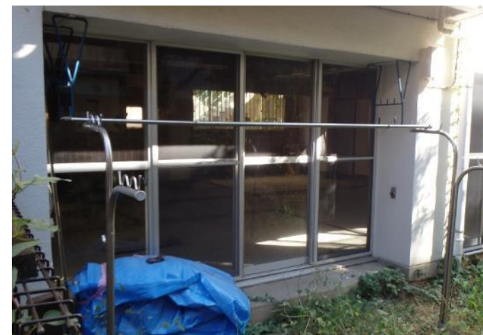
4つの障子が可動な大型サッシ 次の取替えでは1枚は固定になる見込み
