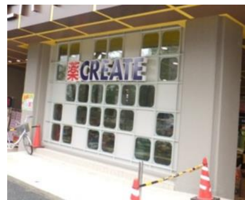
鉄骨パネル補強 (ISGW)
