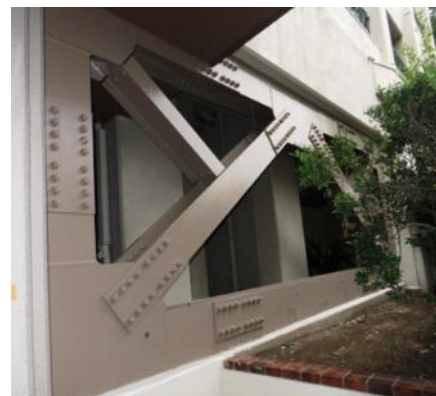
枠組み鉄骨ブレース
