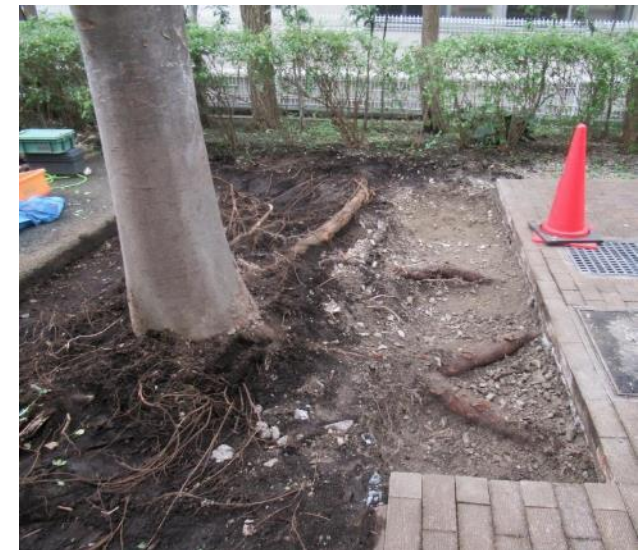
舗装を押し上げてしまった根 写真提供：プランス設計
