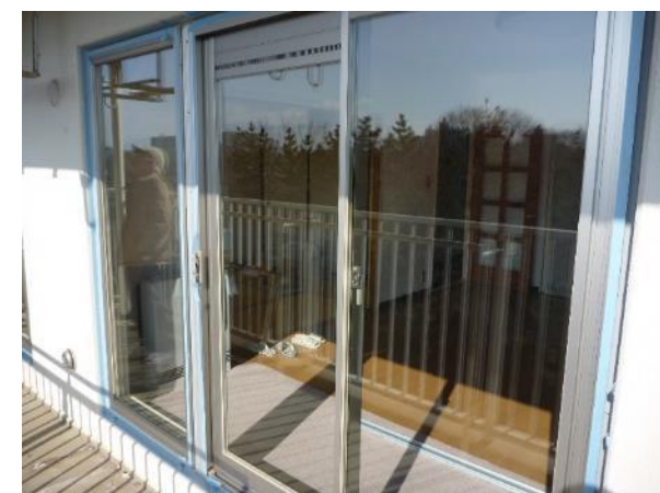
新規アルミサッシ施工完了
