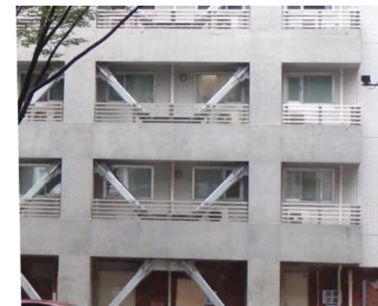
SRCフレーム+鉄骨ブレース
