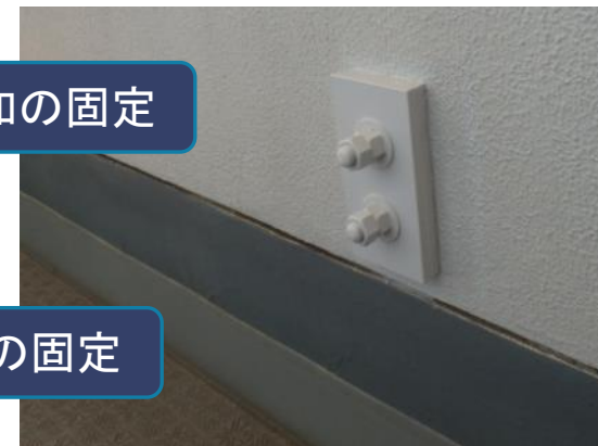
廊下の壁に固定（廊下内側）
