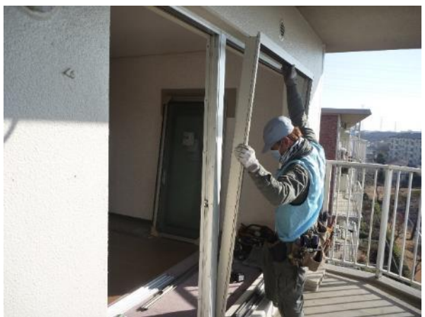
新規枠建て込み
