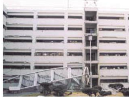
阪神淡路大震災 鉄骨階段が転倒
