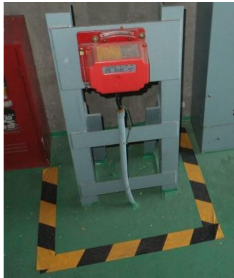
地震感知器 (地震時管制運転装置と連動)
