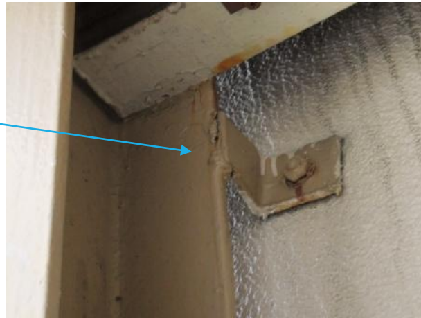
鉄骨階段の取付け部、溶接の接点が少なく、固定の箇所が少ない
