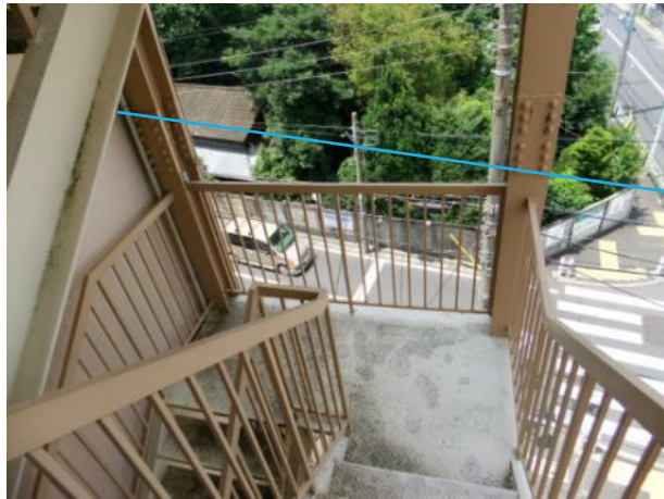
鉄骨階段の取付け部、溶接の接点が少なく、固定の箇所が少ない
