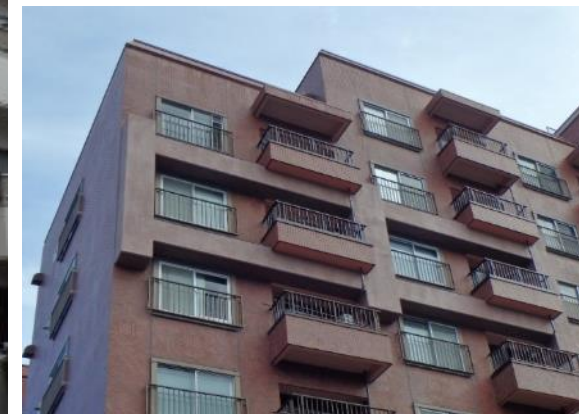
RCフレーム補強
