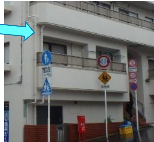
RCフレーム補強
