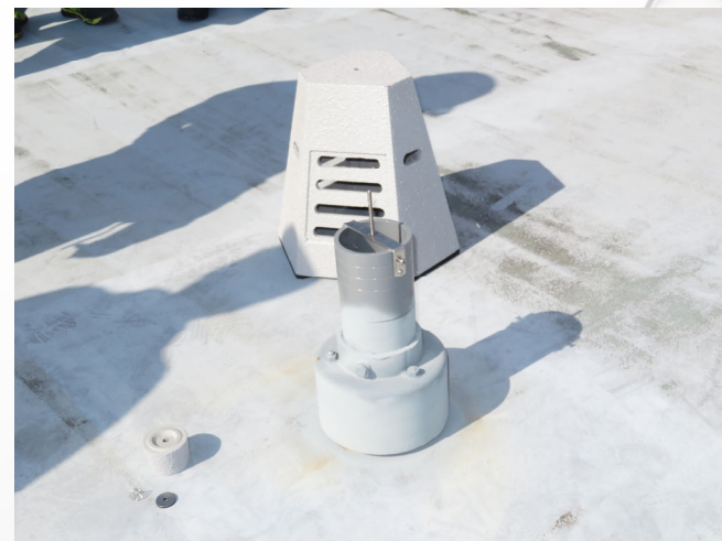
屋上通気金物を脱着が容易で腐食しないGRC製通気部材へ更新
