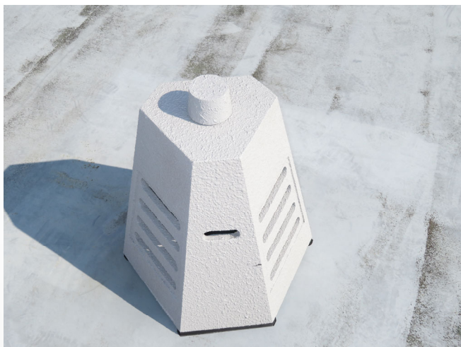
屋上通気金物を脱着が容易で腐食しないGRC製通気部材へ更新
