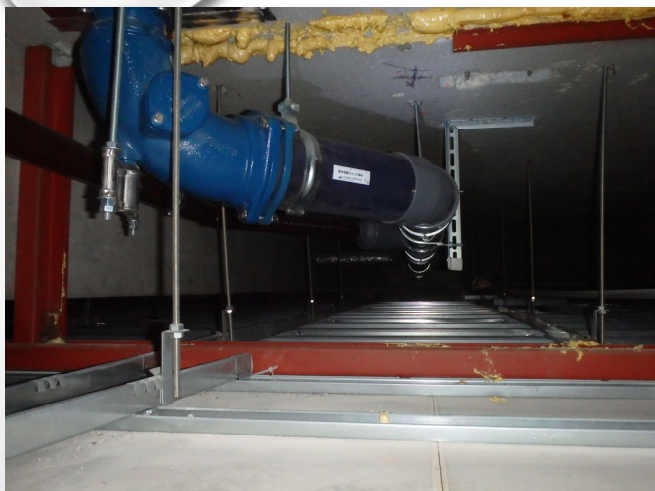
透明塩ビ管の設置
