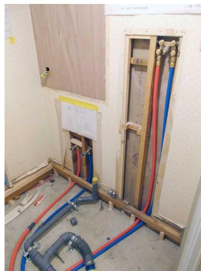
(左上)洗面室の床下配管の状況。給水・給湯管と排水枝管。黄色部分は洗濯機パンの接続口。
