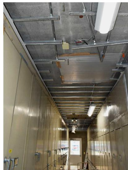
1階貸倉庫室天井に2階床下ピットへの侵入口を新設し、排水管更新作業や将来の保守作業を容易にした。
