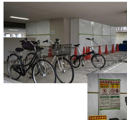
1階ピロティ天井内排水管更新時に、微量アスベスト含有（レベル3）の既存天井材を撤去処分して更新。
