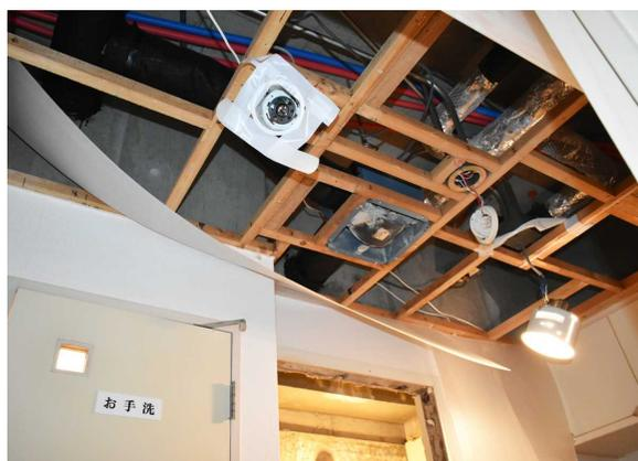
スラブ下排水枝管を撤去。天井内に給水、給湯、追い焚き管を配管。
