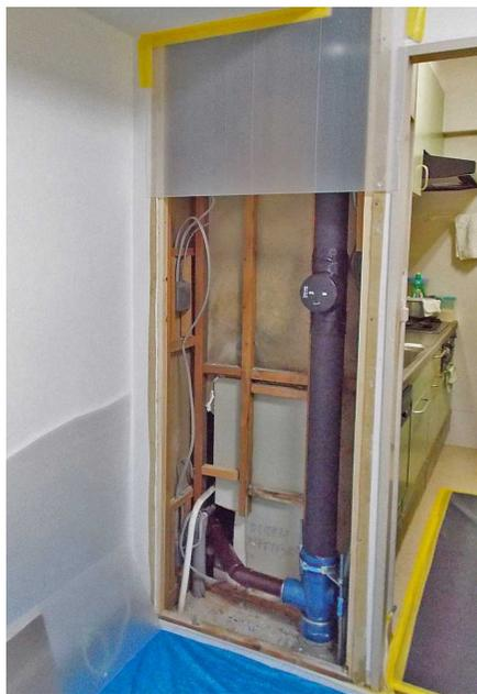
台所系統排水立主管PS内部の配管。褐色が立主管。下部の青色部分が継手、その左が台所用排水枝管。給水・給湯管はまだ配管されていない状態。
