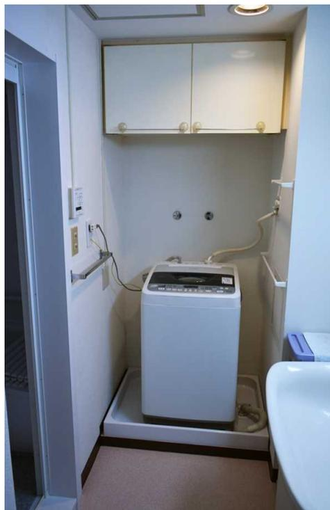
内装仕上げ後の洗面室。床材、天井材、壁面クロスはすべて更新。洗濯機パンも全戸更新した。
