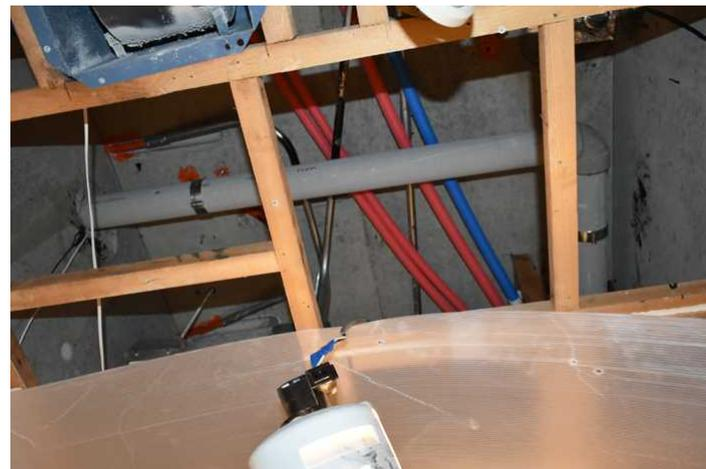
在来浴室の住戸は浴室用排水枝管が鋼管を樹脂管に変更しスラブ下に残る。
