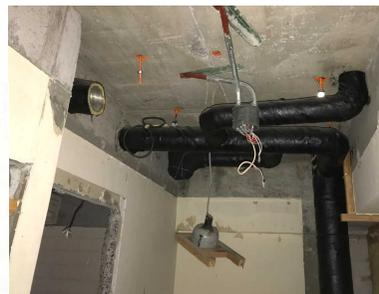
階下住戸の洗面室天井内に配管された上階住戸のスラブ下排水枝管 (写真)
