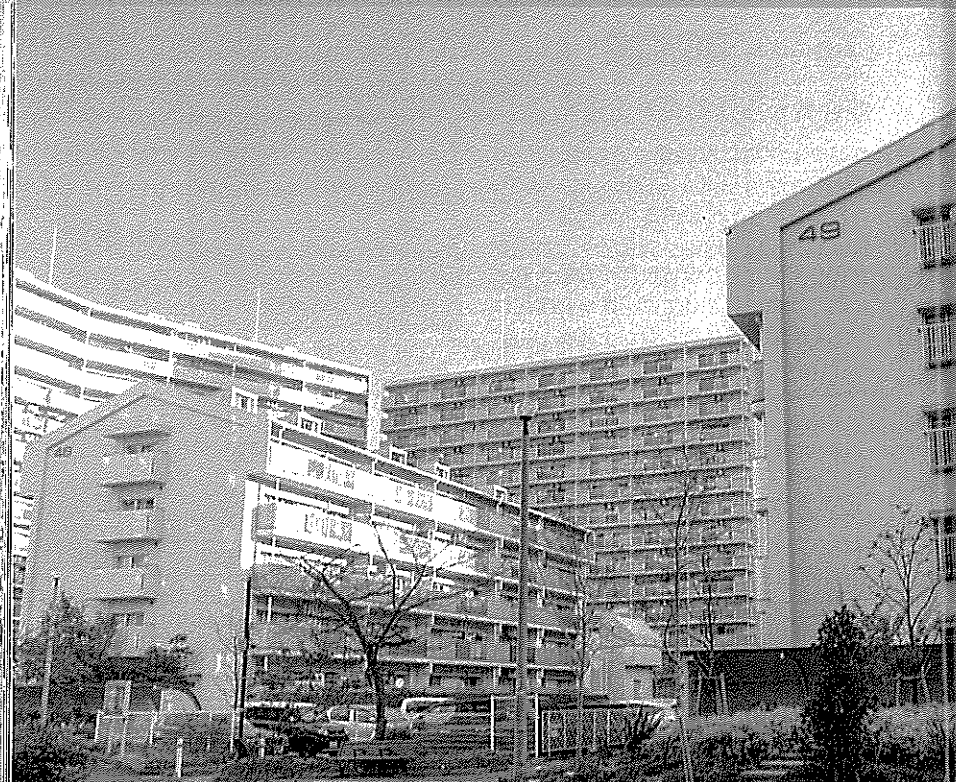
ポートアイランド住宅「コミュニティクラブ」 (兵庫県神戸市)
