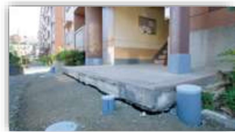
5棟中2棟が傾斜したほか、水道管の破損、給水タンクの破損等の被害を受けた
