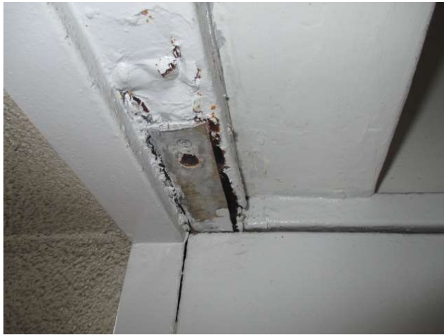
7階非常扉上部
