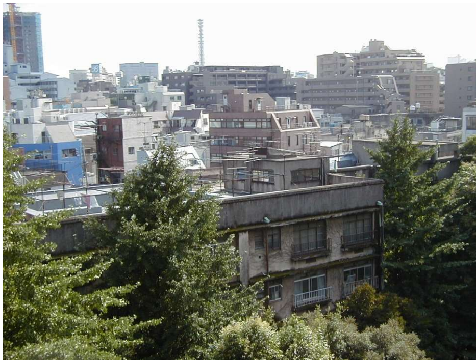
1号棟から2号棟を見た写真
