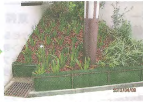
樹脂製メッシュしがらによる改修後
