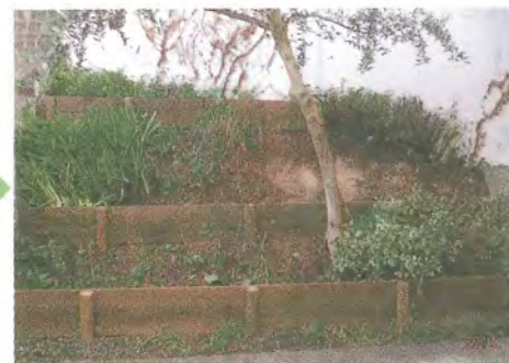
木製しがらによる改修後
