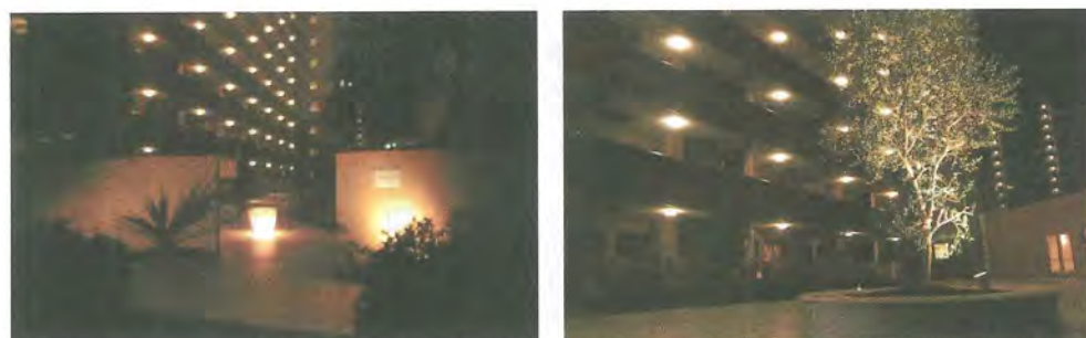
夜間の見栄えと安全性も考慮して照明を配置しています
