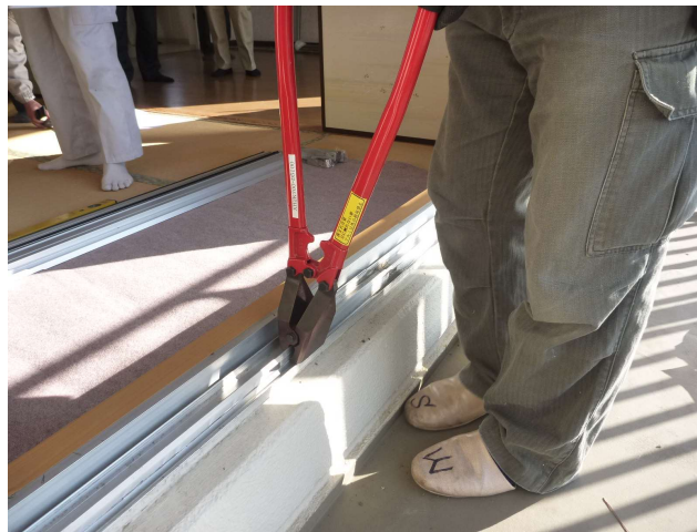
下枠レールカット
