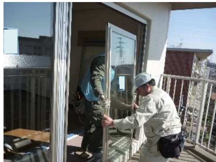
枠カバー工法によるサッシの更新
