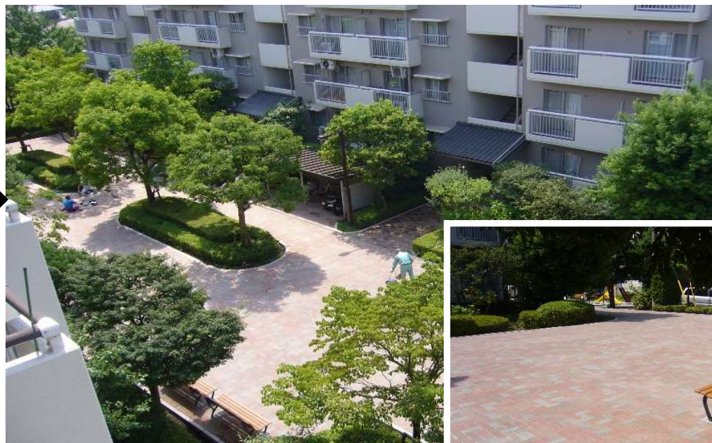
インターロッキングブロック舗装による改修
