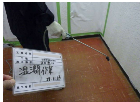
改修工事時のアスベスト含有床仕上げ材の撤去作業
