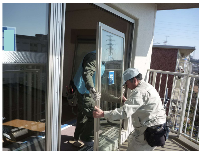
新規障子建て込み
