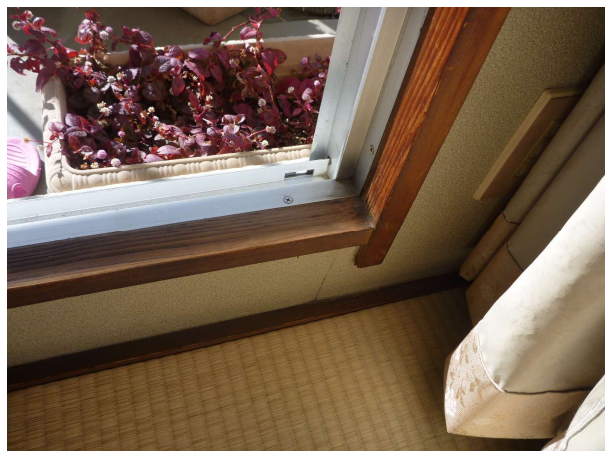
既存窓の木枠
