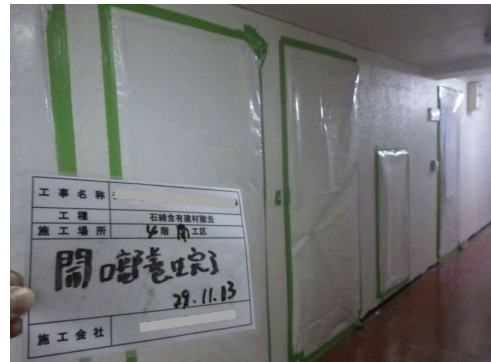
改修工事時のアスベスト含有床仕上げ材の撤去作業
