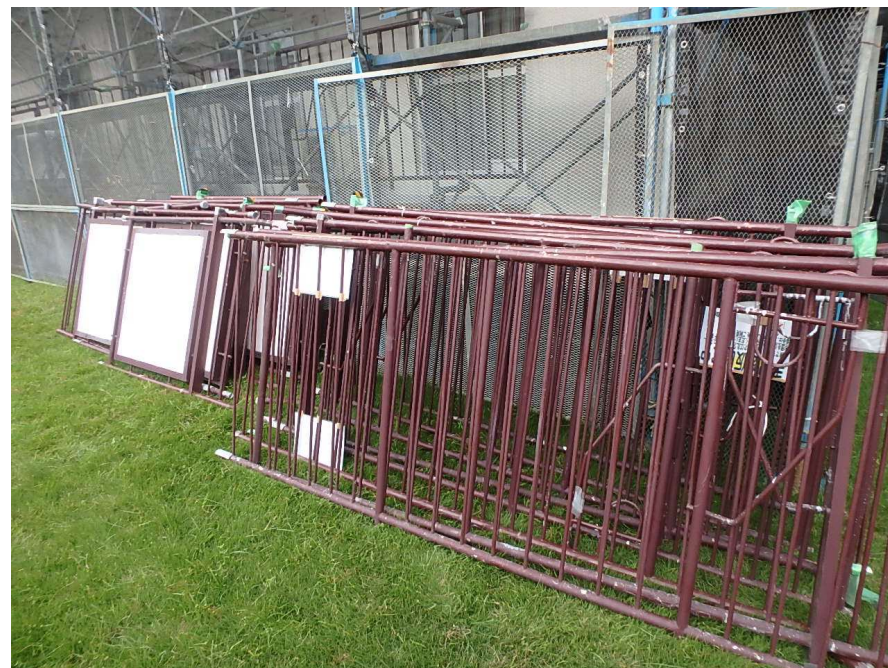
鋼製手すり金物撤去部材
