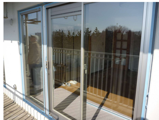
新規アルミサッシ施工完了
