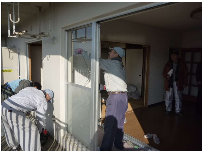
旧サッシ障子取り外し
