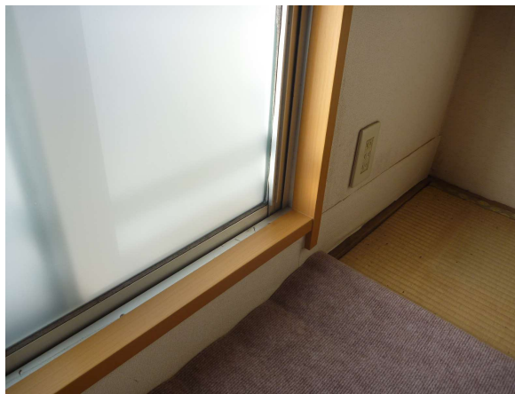
硬質塩ビフィルムによる木枠ラッピング
