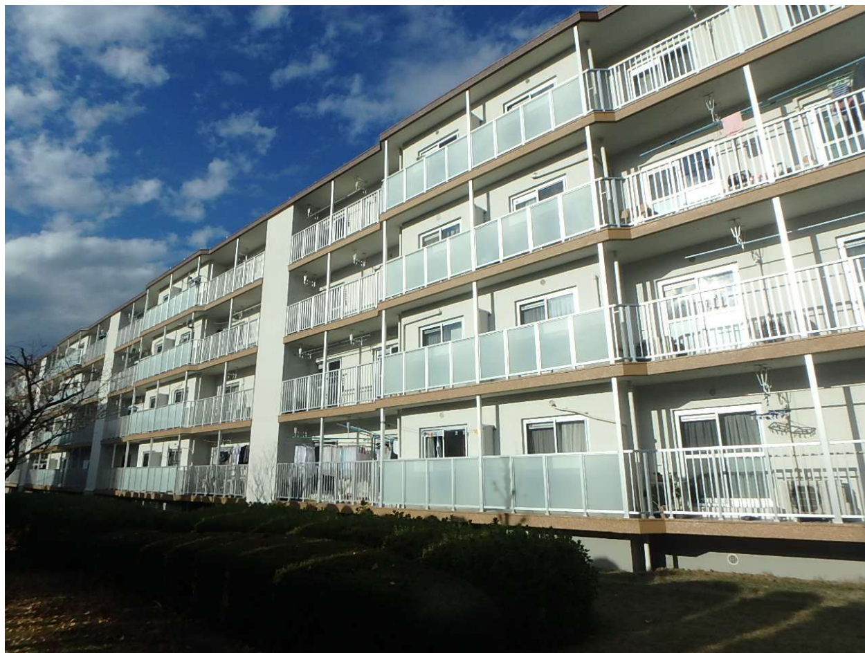
新規アルミ手すり金物（全体外観）
