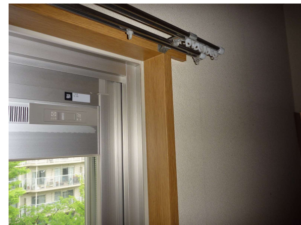
硬質塩ビフィルムによる木枠ラッピング
