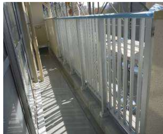
スチール製手摺更新（アルミ手摺化）
