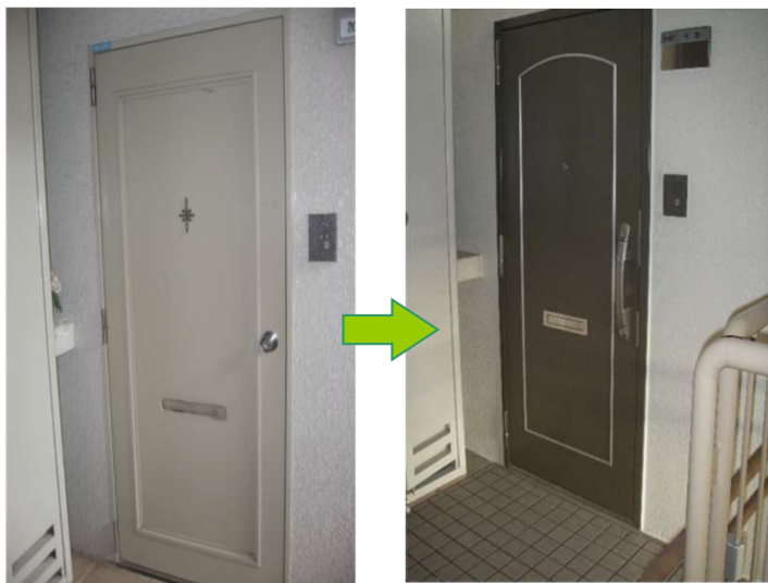
玄関扉の更新
