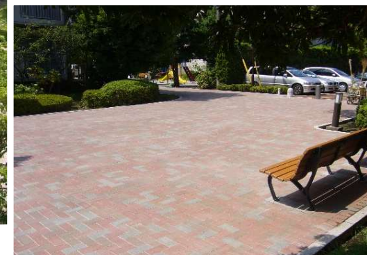
インターロッキングブロック舗装による改修
