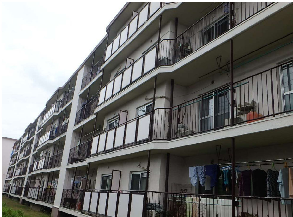
従前の鋼製手すり金物（全体外観）
