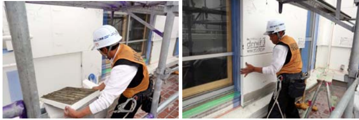
「エステート鶴牧4・5住宅」施工状況 壁の外断熱工事
