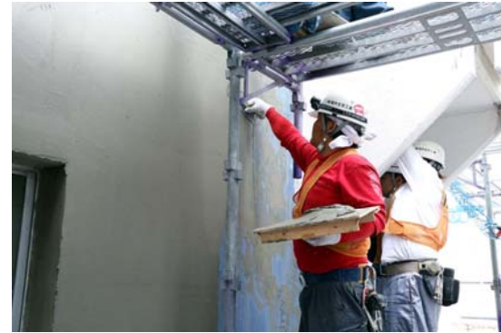
「エステート鶴牧4・5住宅」施工状況 壁の外断熱工事
